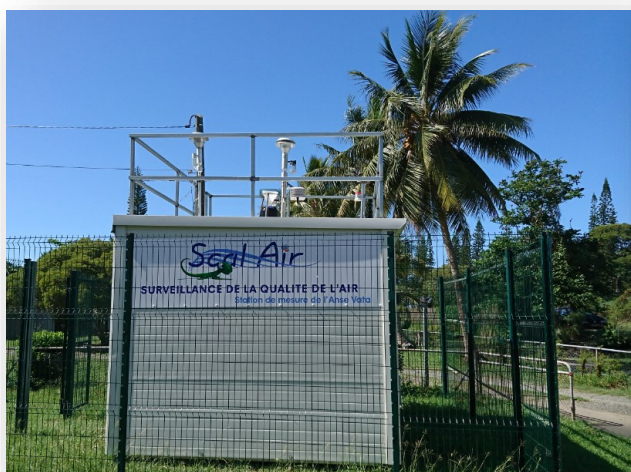
Station Scal'Air de l'anse Vata
